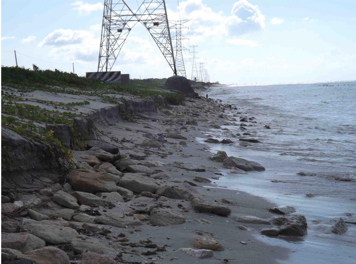
**Figura 4.15.** Las bases de las torres de las líneas de transmisión de energía eléctrica ya estas expuestas, pues la pérdida de material arenoso es evidente a lo largo de esta playa.
