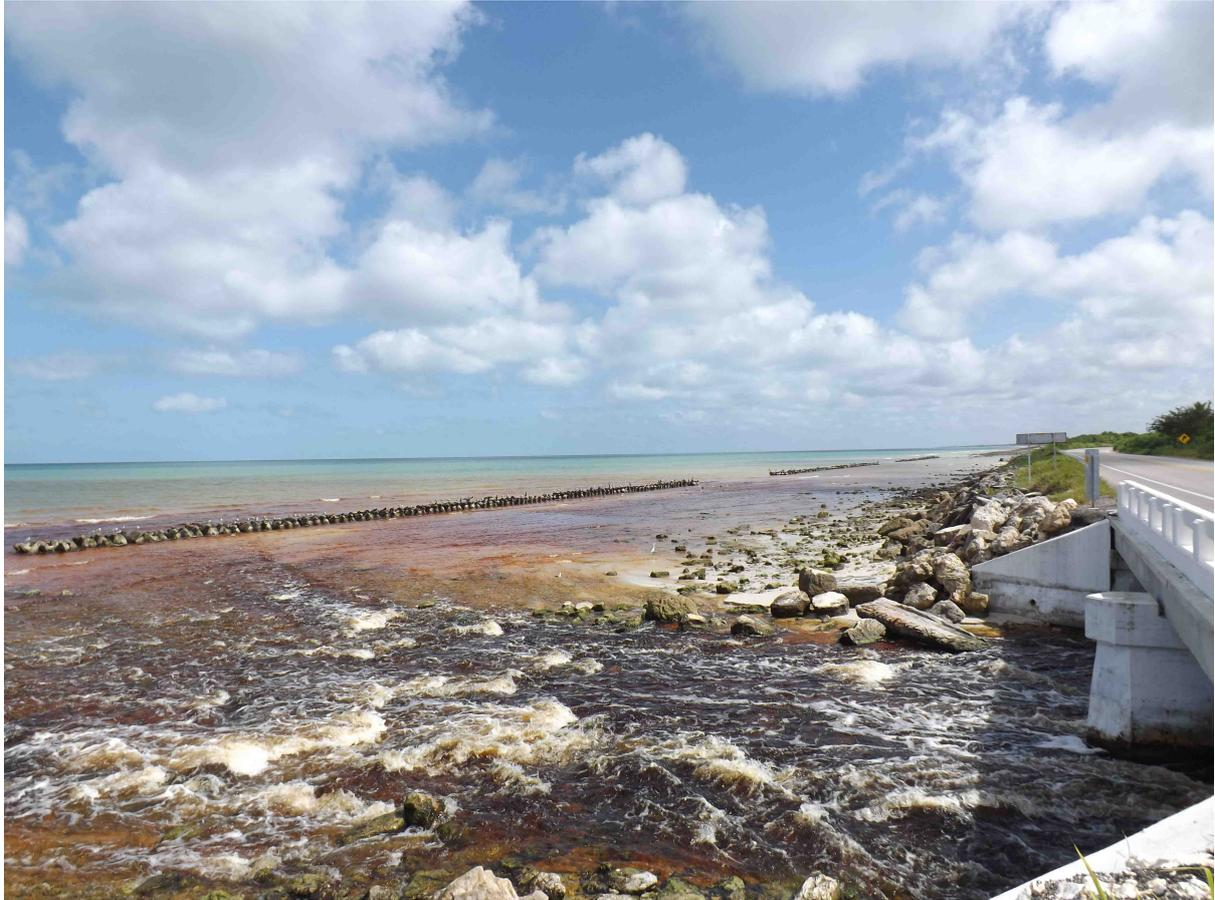
**Figura 4.31.** Descarga de agua proveniente de los manglares, se puede observar la fila de tetrápodos, lo cuales atrapan sedimentos en la parte alta de la playa.
