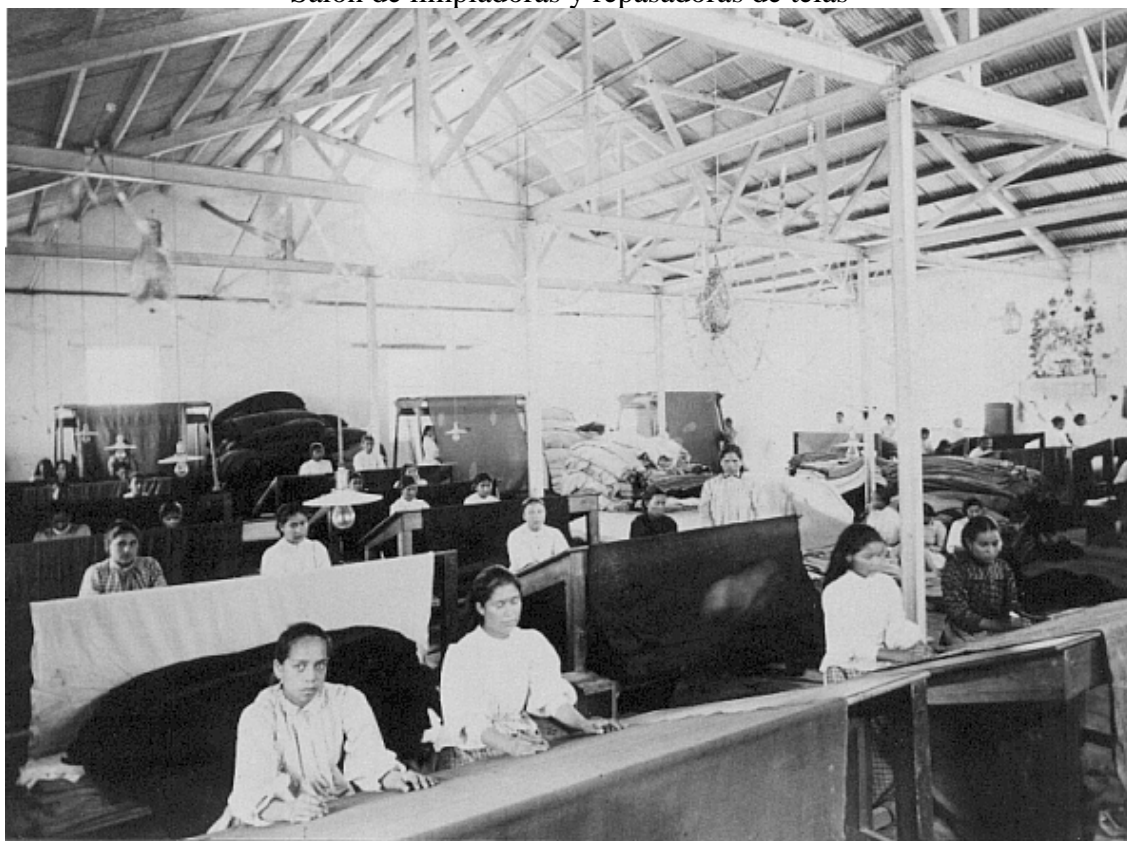
Salón de limpiadoras y repasadoras de telas
