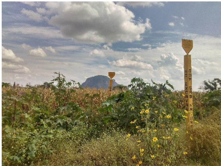
Campos de cultivo de Amilcingo en los que se ven los postes del Gasoducto Morelos.
