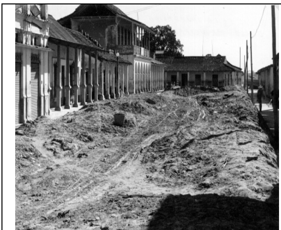
Calles de Tuxtepec, Oaxaca, daños ocasionados por las inundaciones del río Papaloapan: Fuente: SRH, Temascal, 1980.
