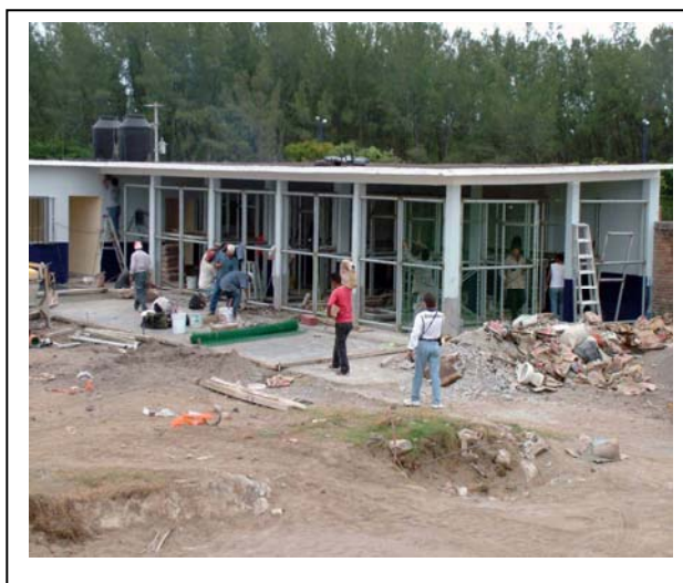
Construcción de la unidad
