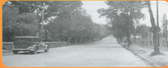
Calzada de Tlalpan, 1938
