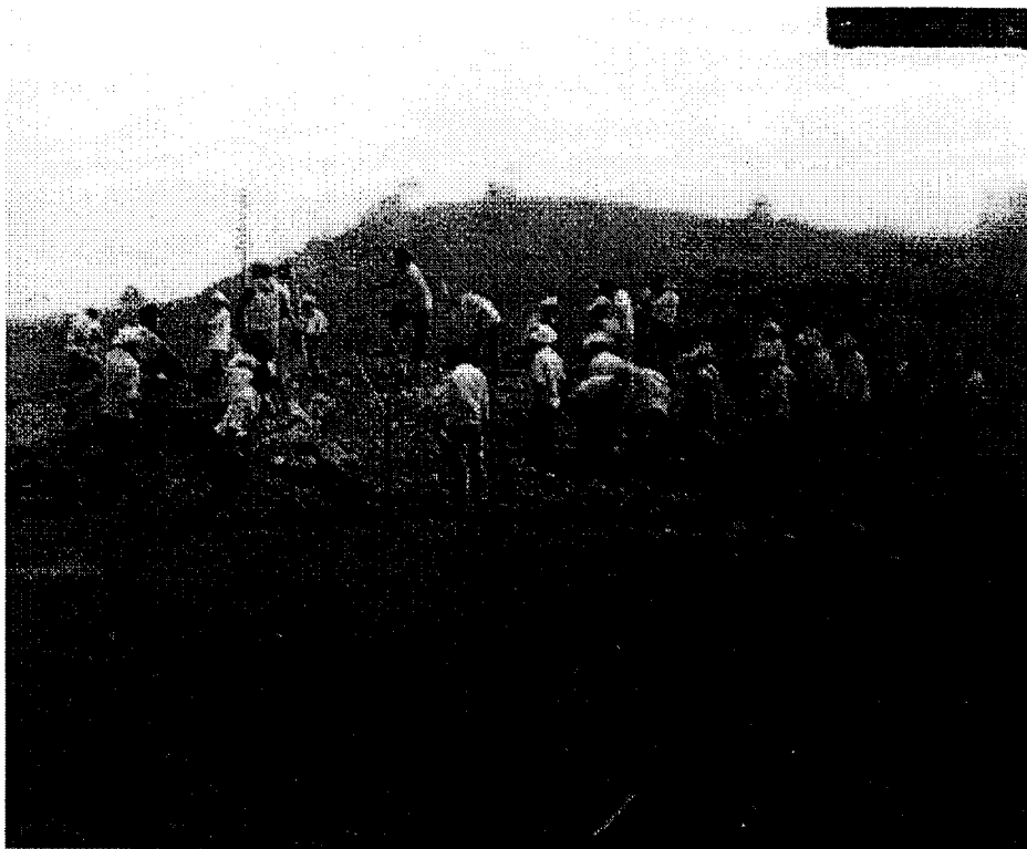
Foto 3 Comuneros haciendo trabajo comunitario para empezar la edificación de la capilla Foto: Rosendo Montiel (mayo de 1994)
