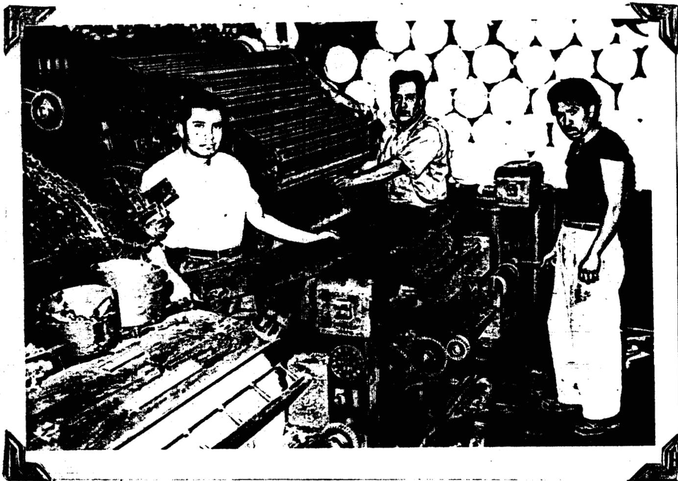
Mecánicos de la fábrica "El León", reparando una "carda". En esta máquina es tratado el rollo de "napa" de los "batientes", para transformarlo en una "mecha", que al ser trenzada paulatinamente en procesos posteriores se convierte en hilo. Los mecánicos representan hasta la fecha al grupo de trabajo más calificado e independiente dentro de las fábricas textiles.
