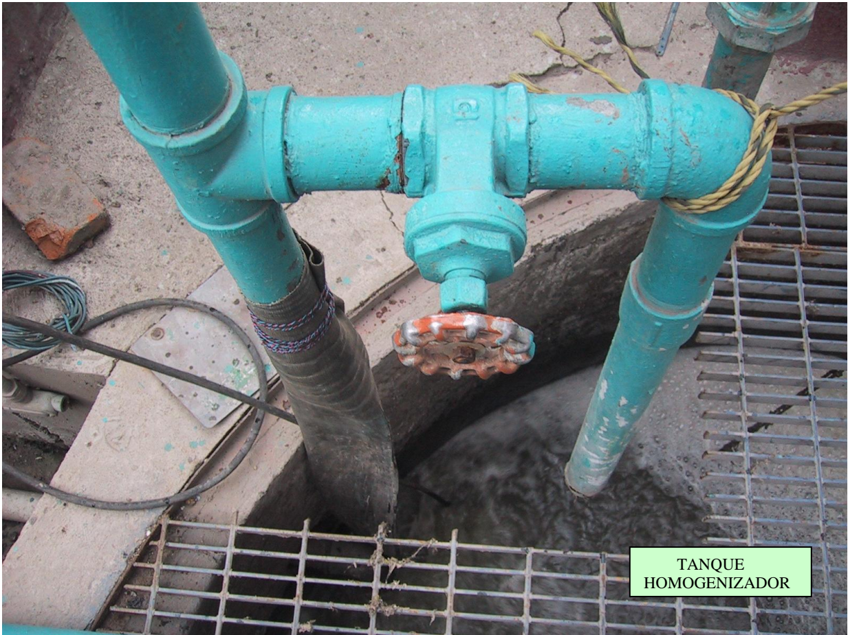
Figura 4.2 Arreglo de tubería para un regreso de agua residual al tanque homogenizador.
