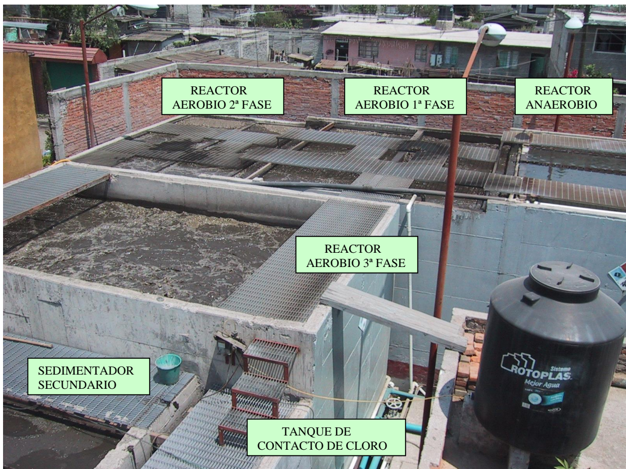
Figura 4.4 Tanque de contacto de cloro y deposito de cloro.
