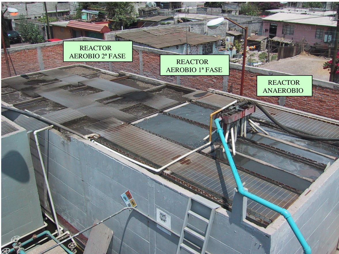
Figura 4.5 Tubería de regreso de lodos (color blanco).
