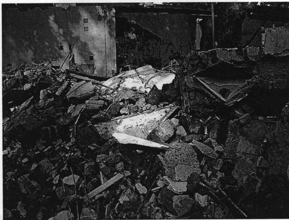
Escombros 5. Demolición de la casa de Checa #18, Chimalistac, DF. Antonio Zirión. 31 de enero de 2006.
