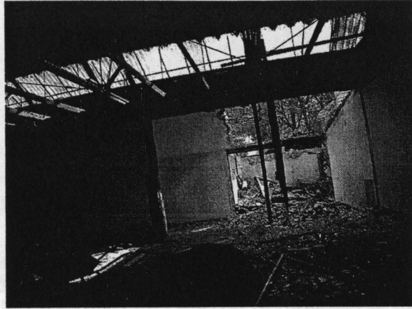
La casa de Checa #18 en proceso de demolición 6. Chimalistac, DF. Antonio Ziri3n. 19 de enero de 2006.
