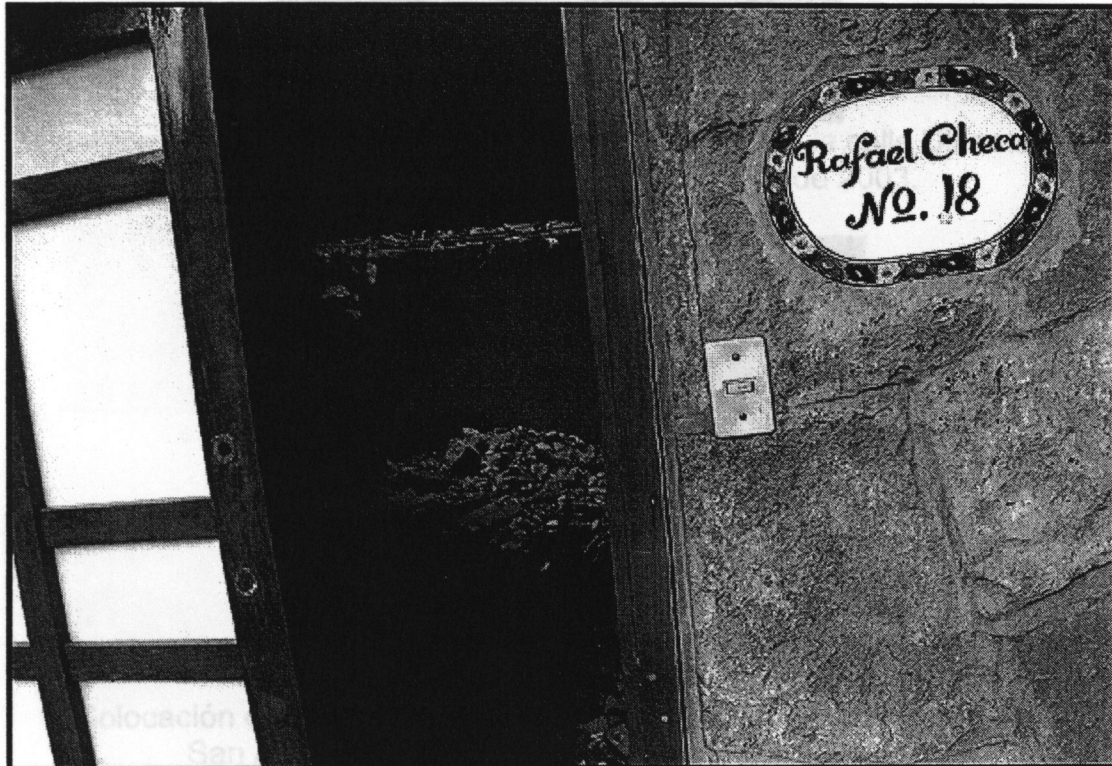
Puerta de entrada a la casa de Checa #18 en proceso de demolición. Chimalistac, DF. Antonio Ziri6n. 11 de enero de 2006.
