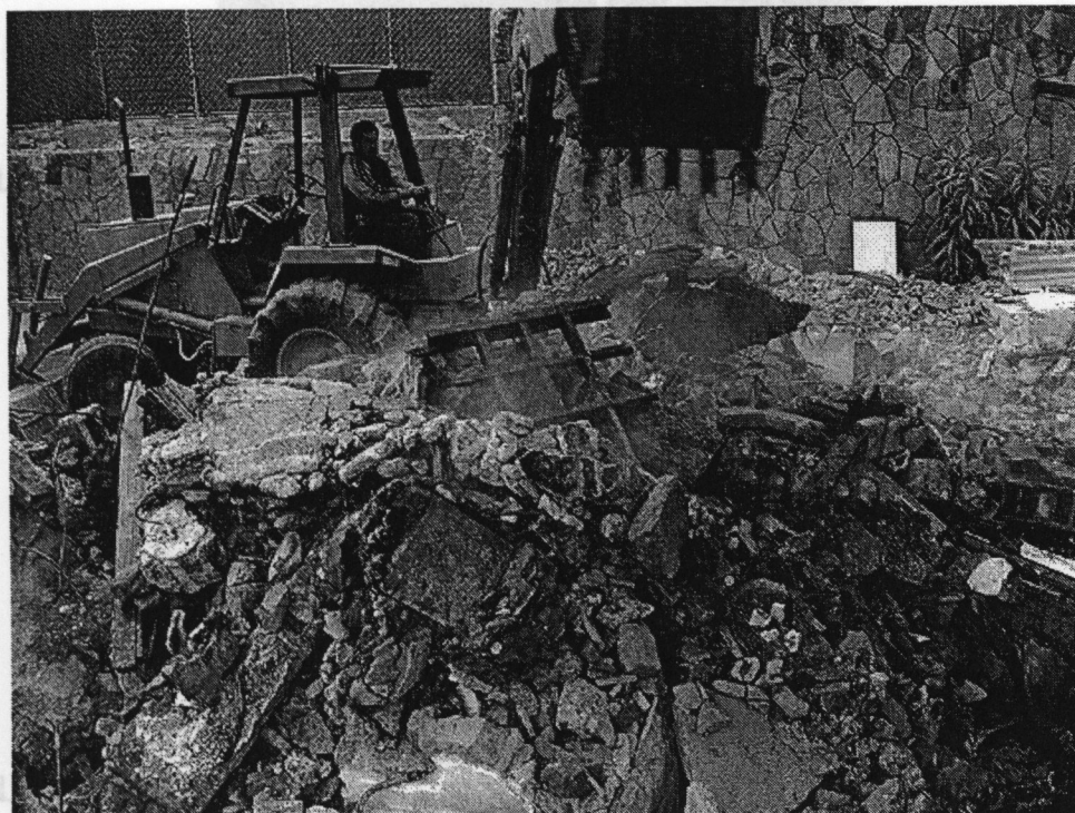
La máquina en acci6n. Demolici6n de la casa de Checa #18, Chimalistac, DF. Antonio Ziri6n. 31 de enero de 2006.
