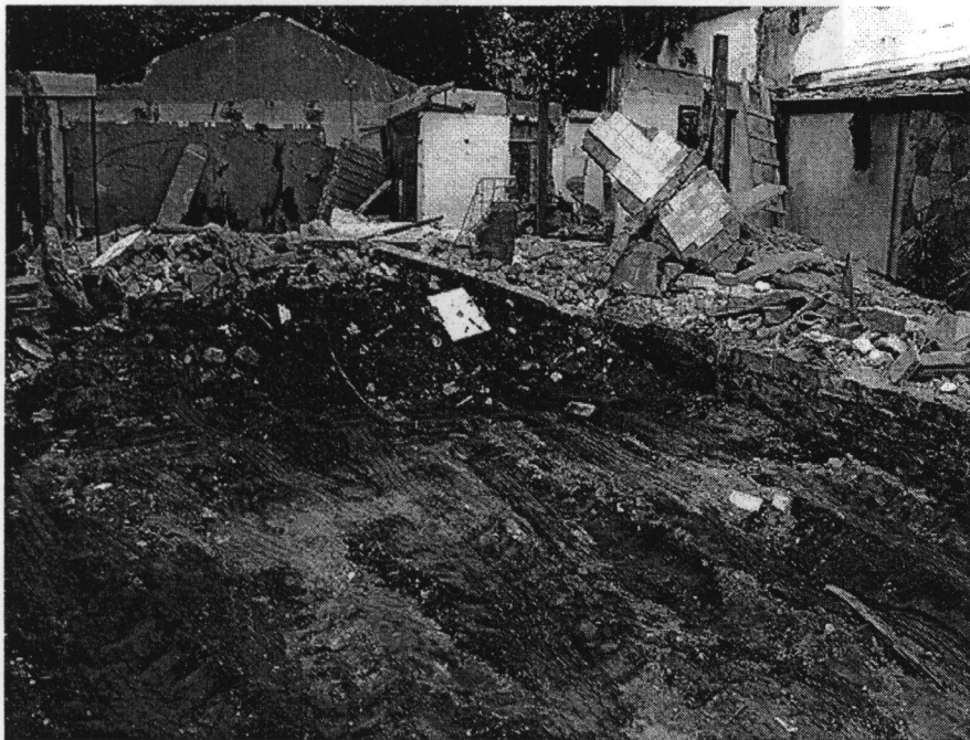
La casa de Checa #18 en proceso de demolición 13. Chimalistac, DF. Antonio Ziri3n. 9 de febrero de 2006.
