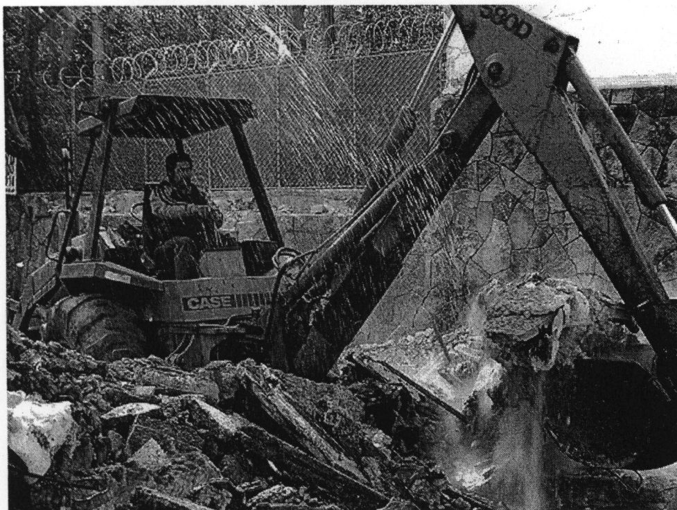
La máquina recogiendo escombros. Demolición de la casa de Checa #18, Chimalistac, DF. Antonio Ziri6n. 31 de enero de 2006.
