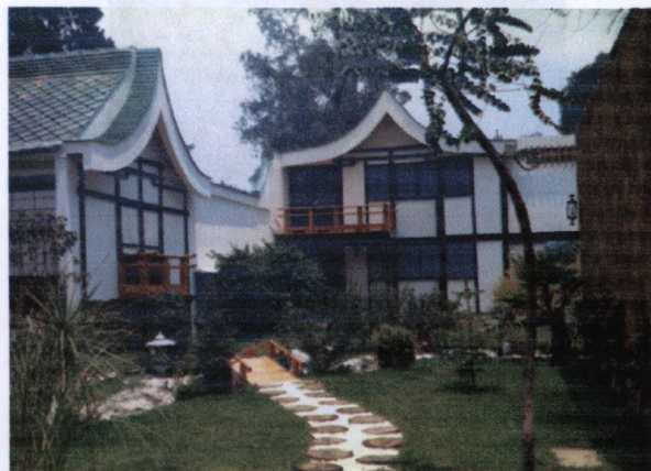
El jardín del squash. Serie tomada para documentar la ampliación de la casa de Checa #18, Chimalistac, DF. Autor desconocido. 1973.
