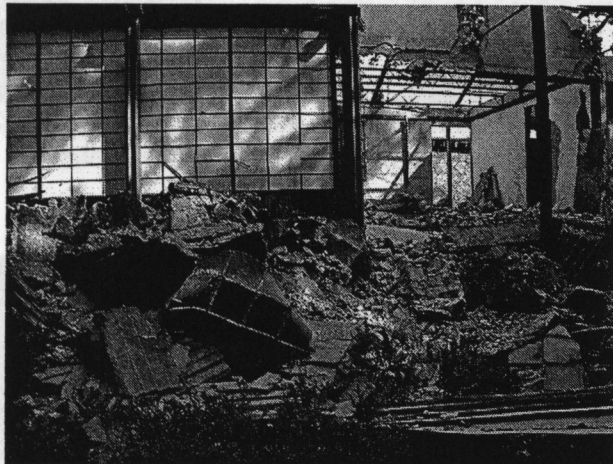
La casa de Checa #18 en proceso de demolici3n 10. Chimalistac, DF. Antonio Ziri3n. 31 de enero de 2006
