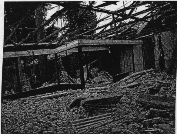
La casa de Checa #18 en proceso de demolici3n 7. Chimalistac, DF. Antonio Ziri3n. 23 de enero de 2006.
