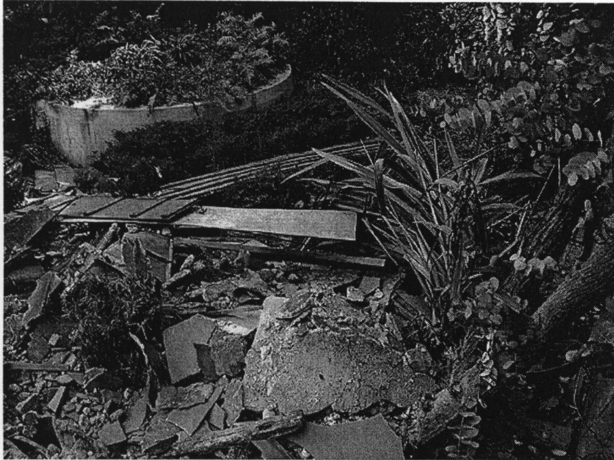
La casa de Checa #18 en proceso de demolición 12. Chimalistac, DF. Antonio Ziri3n. 13 de febrero de 2006.
