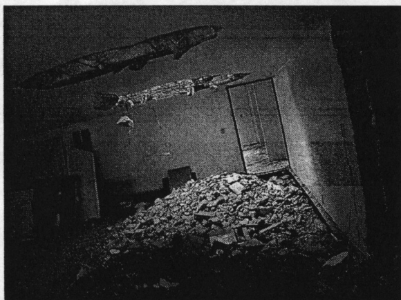
La casa de Checa #18 en proceso de demolición 1. Chimalistac, DF. Antonio Ziri3n. 11 de enero de 2006.
