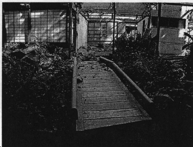
La casa de Checa #18 en proceso de demolici3n 11. Chimalistac, DF. Antonio Ziri3n. 31 de enero de 2006.
