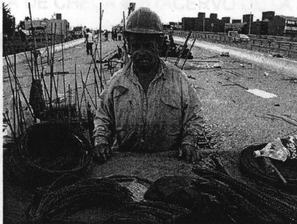
Fierrero en la obra del Segundo Piso del Periférico. San Ángel, DF. Antonio Ziri3n, 31 de enero de 2006.
