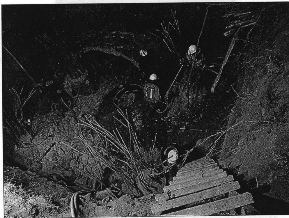
Obreros trabajan en un hoyo en la obra del Segundo Piso del Periférico. San Ángel, DF. Antonio Zirión. 31 de enero de 2006.
