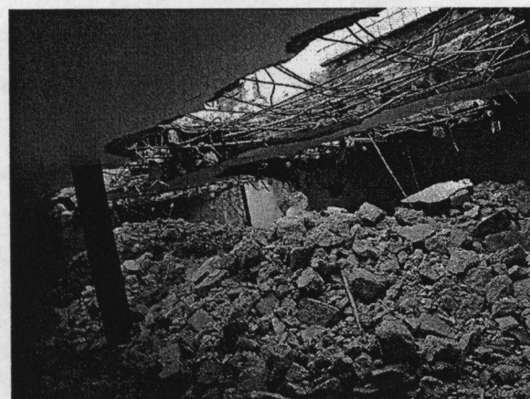
La casa de Checa #18 en proceso de demolición 3. Chimalistac, DF. Antonio Ziri3n. 16 de enero de 2006.
