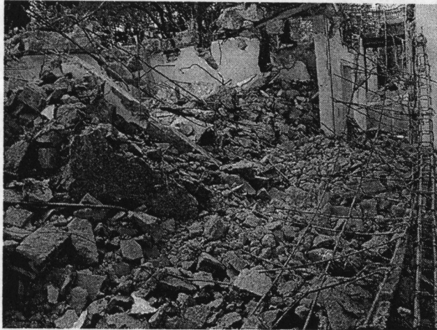
Escombros 1. Demolición de la casa de Checa #18, Chimalistac, DF. Antonio Zirión. 19 de enero de 2006.
