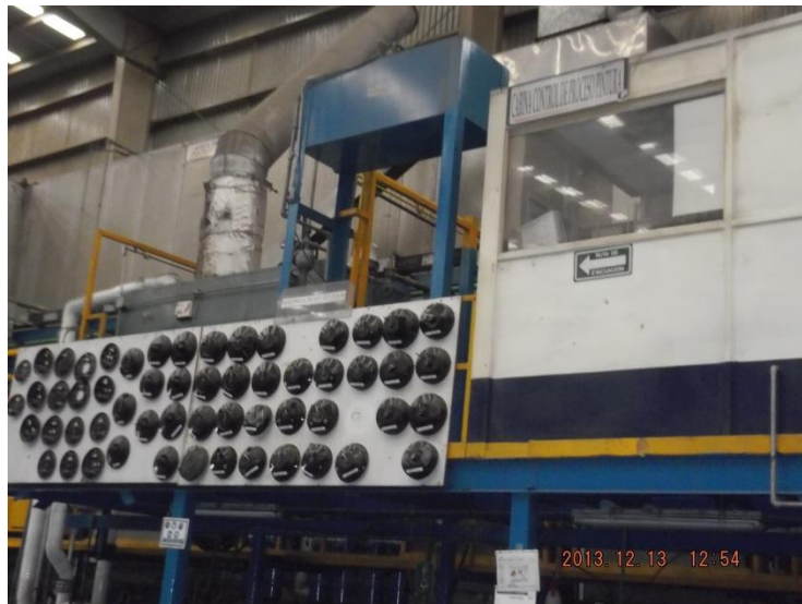
Fotografía No. 10. Exhibición en la cabina de pintura de diferentes tipos de plato para booster que pasan por el proceso de pintura, con su respectivo número de parte (área de pintura, unidad de metal)
