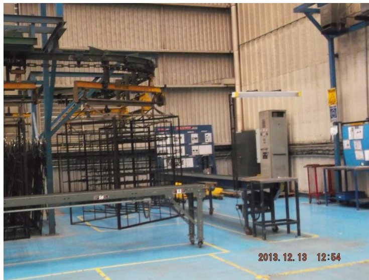
Fotografía No. 11. Racks (soportes metálicos) en la primera banda transportadora que surten la cabina del proceso de pintura por inmersión (área de pintura, unidad de metal)
