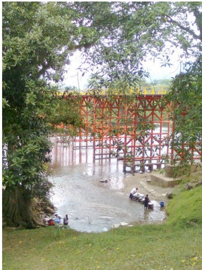
Puente que comunica al ejido con la carretera Oaxaca-Tuxtepe construido durante la administración de Vicente Fox. Manantial donde la población acude con regularidad a lavar su ropa, trastes y a bañarse.
