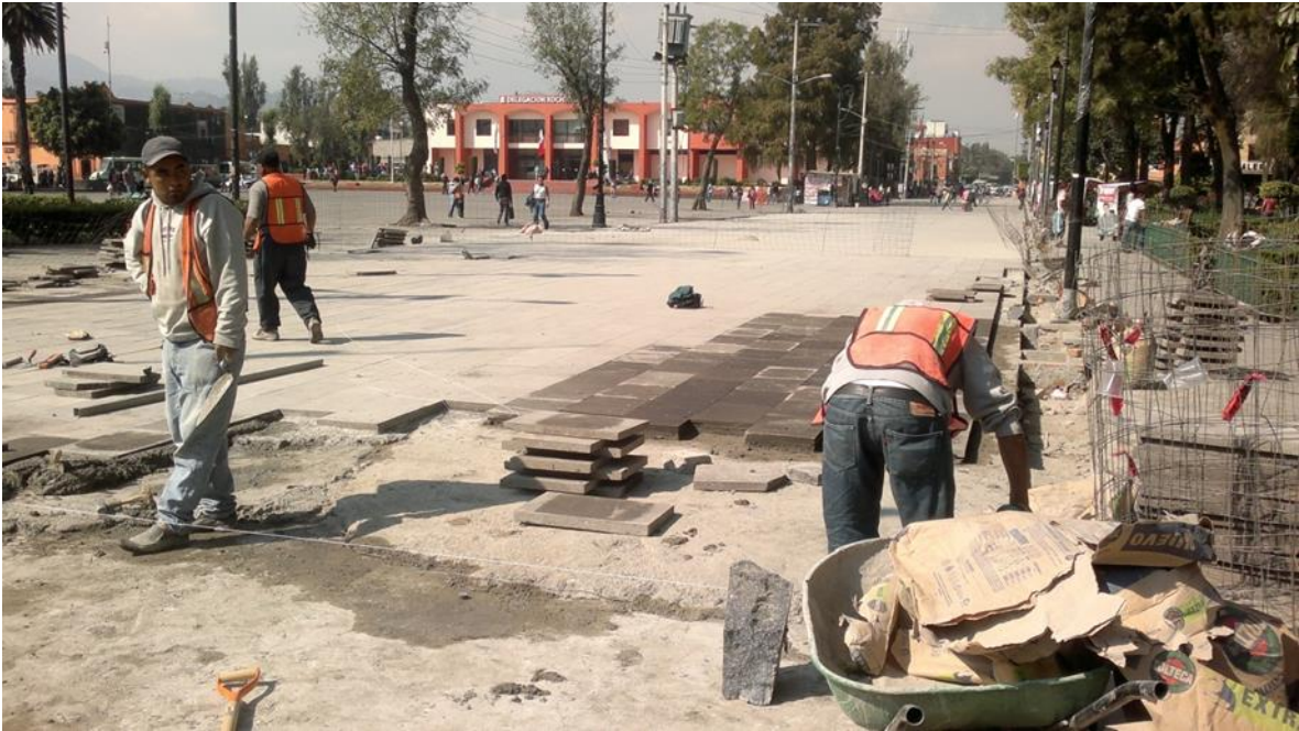
30. Remodelación del corredor Guadalupe I. Ramírez. Fotografía de Adrián Pacheco.
