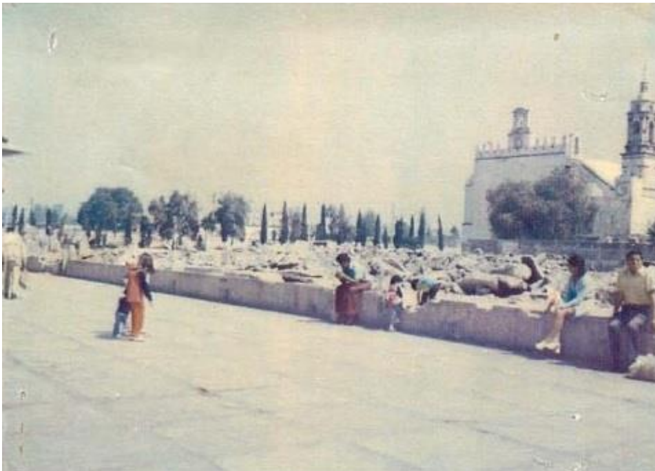
44. Demolición de las escuelas en el atrio de San Bernardino. Fotografía del expediente de San Bernardino DGSMPC, CONACULTA.
