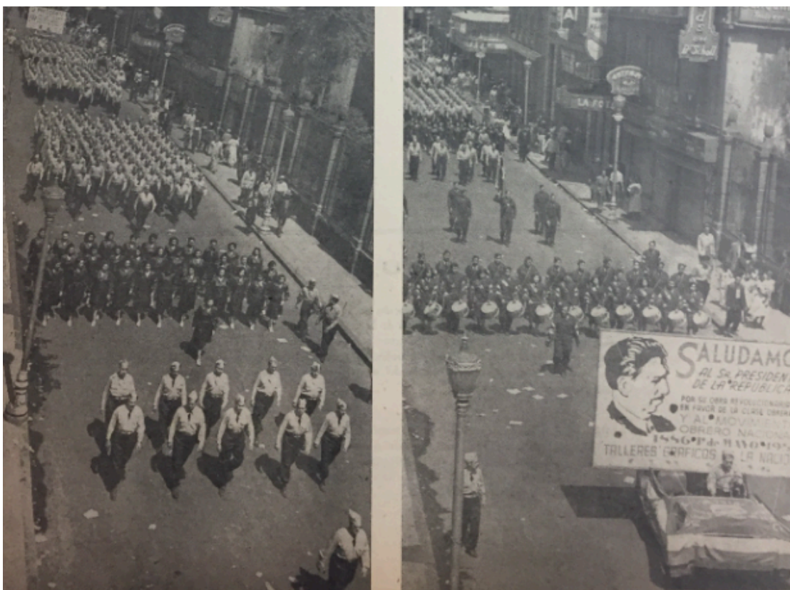
Figura 26. Toma superior de la sección 5 del SITAG desfilando en la calle de Madero
