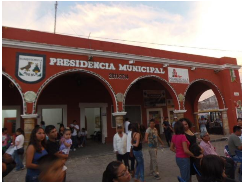
Fotografía 25. Fachada de Presidencia Municipal de Huaquechula. Capturada por el autor (2013).
