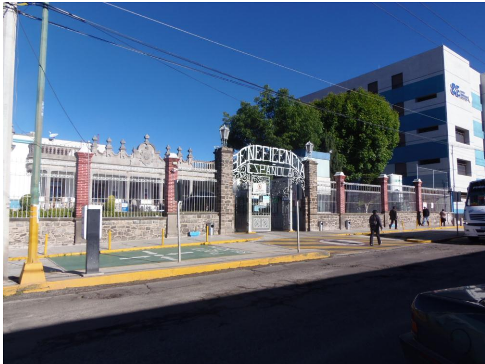
Fotografía 11. Fachada original del hospital Beneficencia Española. Ejemplo de la solidaridad entre los migrantes españoles en Puebla. Capturada por el autor (2015).
