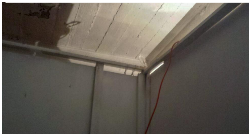
Foto 1. Techo del cuarto maduradora, desde el interior de la habitación de Marcela
