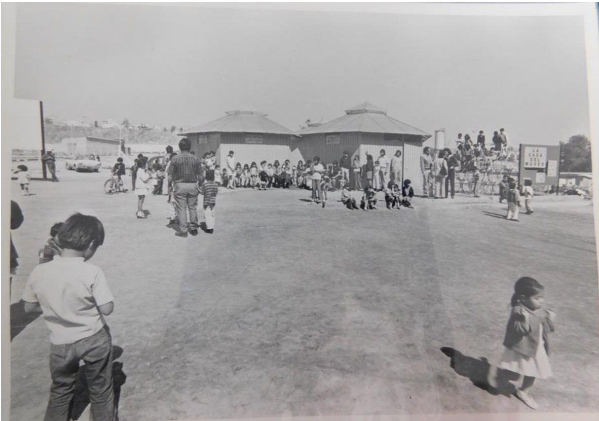
Ilustración 29. Vista general de La Casa del Museo, ca. 1974. 83
