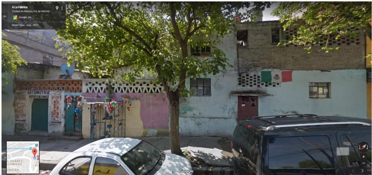
Ilustración 112. Casas de la calle La Fábrica que quedaban frente a La Casa del Museo. Captura de pantalla de la vista en Google maps, street view, en 2018.
