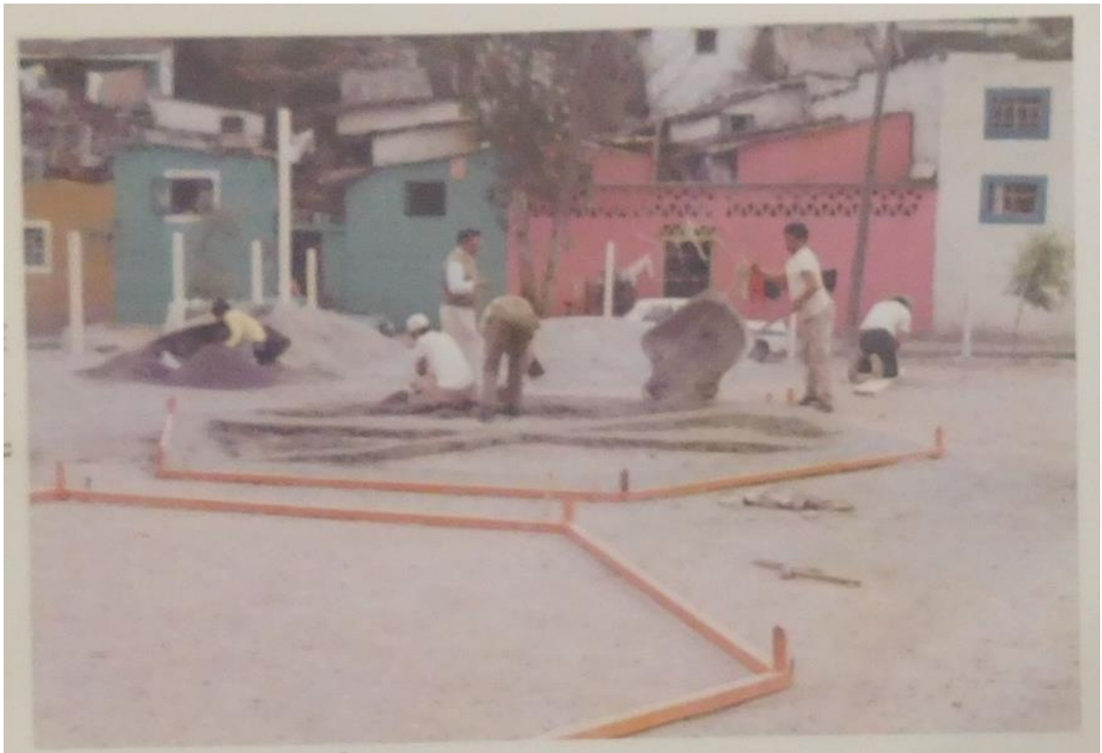
Ilustración 28. Primeros trabajos para la instalación de los módulos. Octubre 1973. 81
