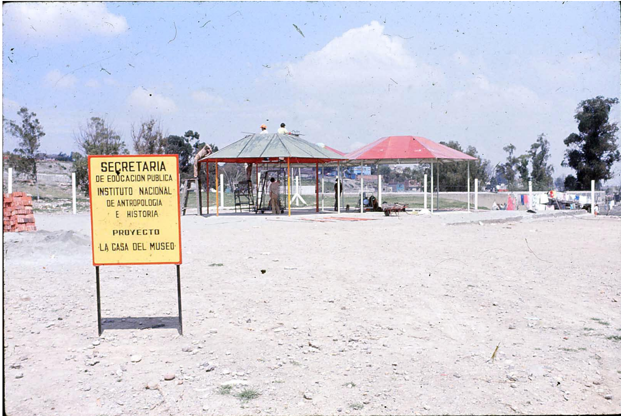
Ilustración 23. Primeros trabajos para la instalación de los módulos. Octubre, 1973. 75
