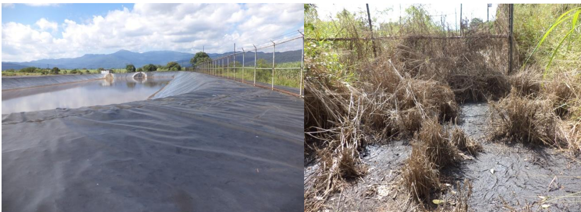
Fotografías del año 2013, a la izquierda se muestra una de los contenedores con geomembrana que pertenece a la Alcoholera Zapopan y a la derecha vinaza regada de manera involuntaria en el suelo y caña quemada. Fuente: Anónimo
